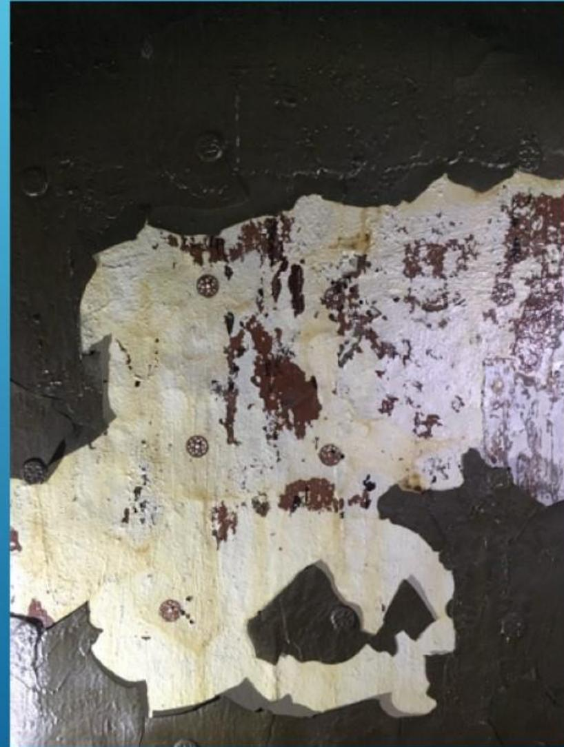
Гидроизоляция солевой породы на гидроизоляционном сооружении в барьерном целике СКРУ-2, (г. Соликамск, 2015 год). Площадь покрытия – 120 м<sup>2</sup>, температура нанесения +5 °С.
