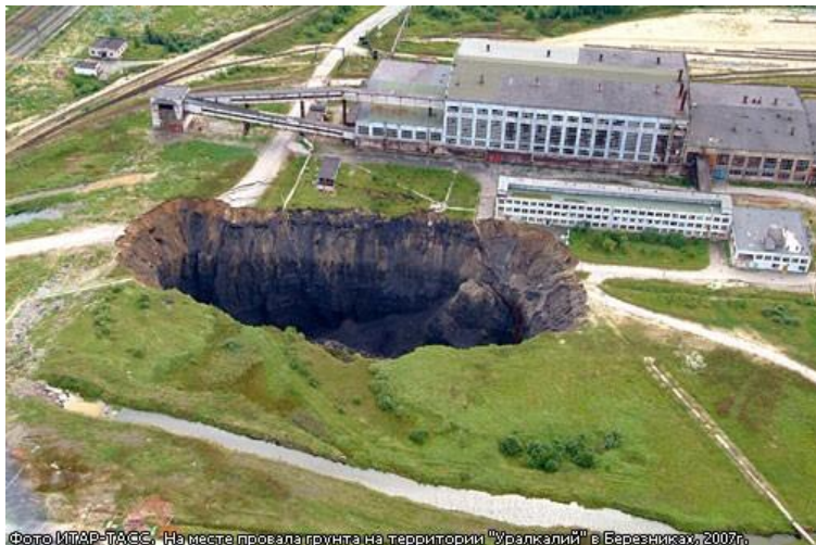
Провал грунта на территории БКРУ-1
